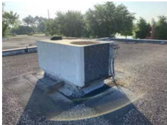
PHOTO # 10 ROOF AREA F1
