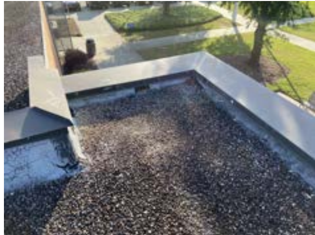
PHOTO # 7 ROOF AREA F1
