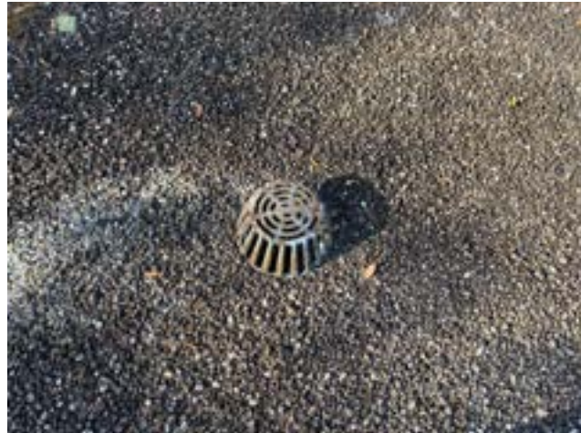
PHOTO # 8 ROOF AREA F1
