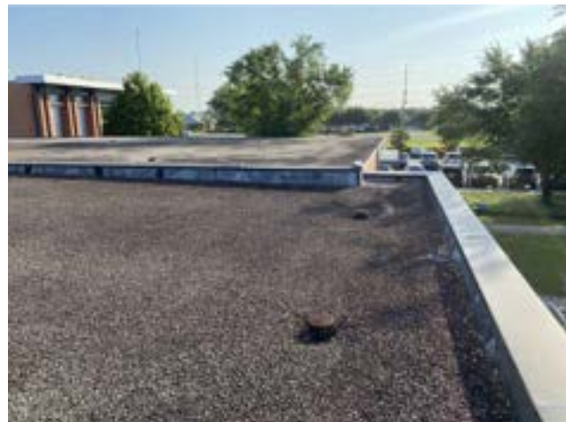
PHOTO # 9 ROOF AREA F1
