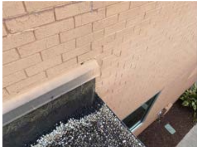
PHOTO # 12 ROOF AREA E1
