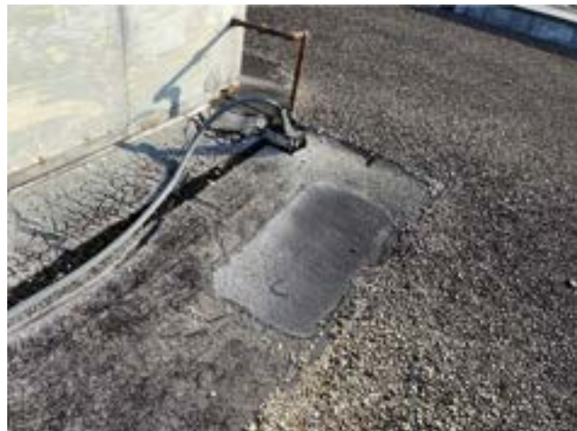
PHOTO # 12 ROOF AREA F1
