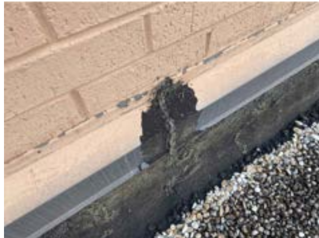
PHOTO # 11 ROOF AREA E1
