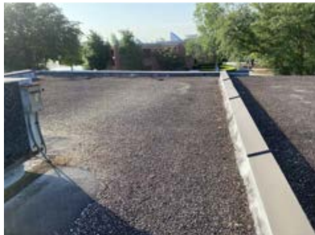
PHOTO # 11 ROOF AREA F1
