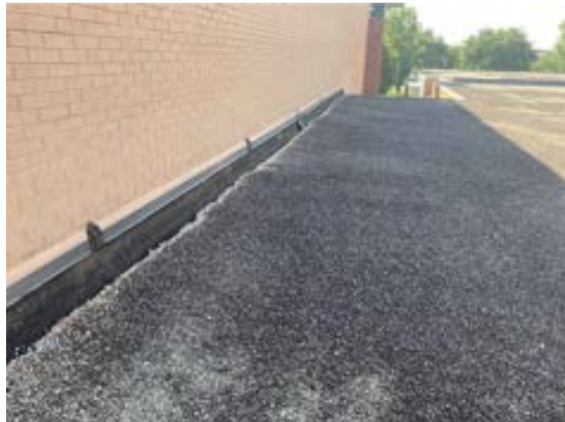
PHOTO # 10 ROOF AREA E1
