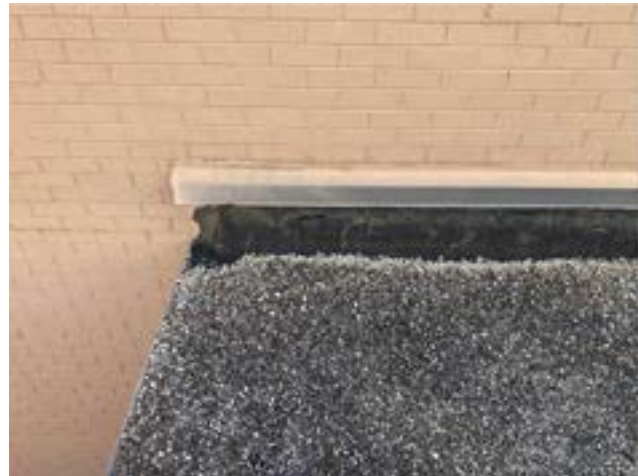
PHOTO # 9 ROOF AREA E1
